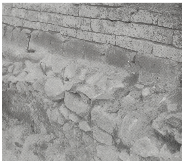
Мал. 7. Падмуркавы выступ і аблямоўка паўднёвай сцяны Мінскага храма (паводле Э. Загарульскага) Fig. 7. Foundation ledge and border of the southern wall of the Minsk church (according to E. Zagarulski)
