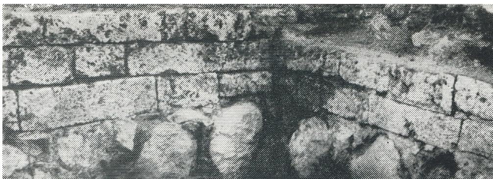
Мал. 9. Аблямоўка сцен храма каменнымі пліткамі (паводле Э. Загарульскага) Fig. 9. Border the walls of the temple with stone tiles (according to E. Zagarulski)
