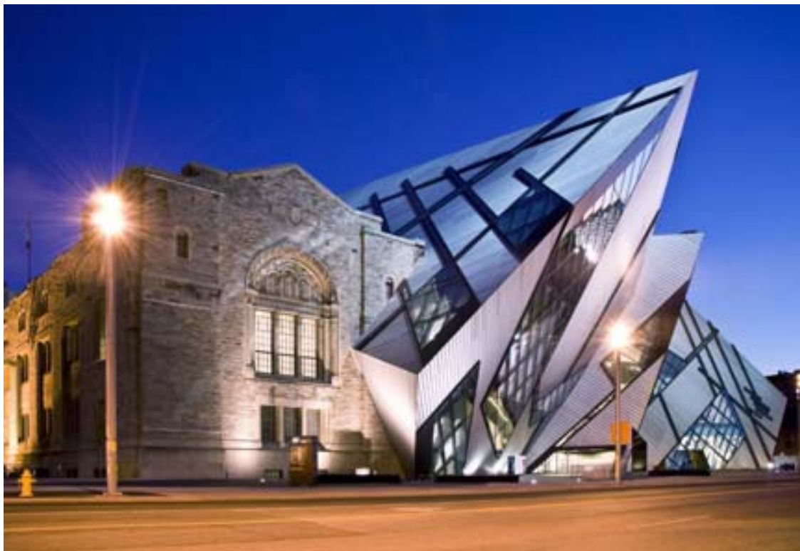
Рис. 5. Здание Королевского музея Онтарио в Торонто (Канада, 2007, арх. Д. Либескинд)
